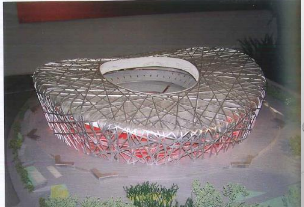
النظام الهيكلي يشبه شبكة محاطة بالكمرات
